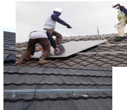
Gambar 9 : Pemasangan modul surya pada reels Sumber: Modul “Panduan perencanaan dan pemanfaatan PV rooftop di Indonesia”
